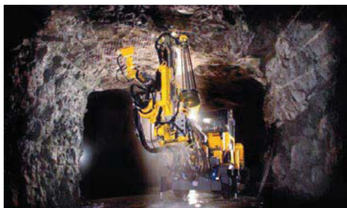
W pełni zmechanizowana zabudowa kotew Swellex z wykorzystaniem kotwiarki Boltec
